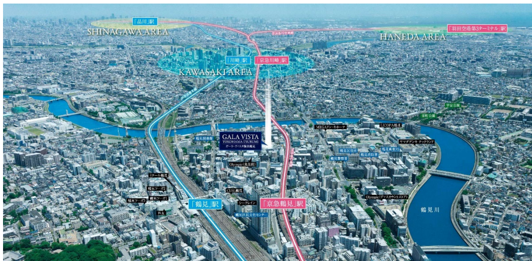
【現地上空からの航空写真】
