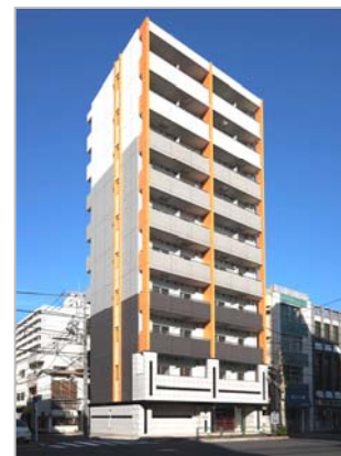
■ ガーラ・シティ深川扇橋
